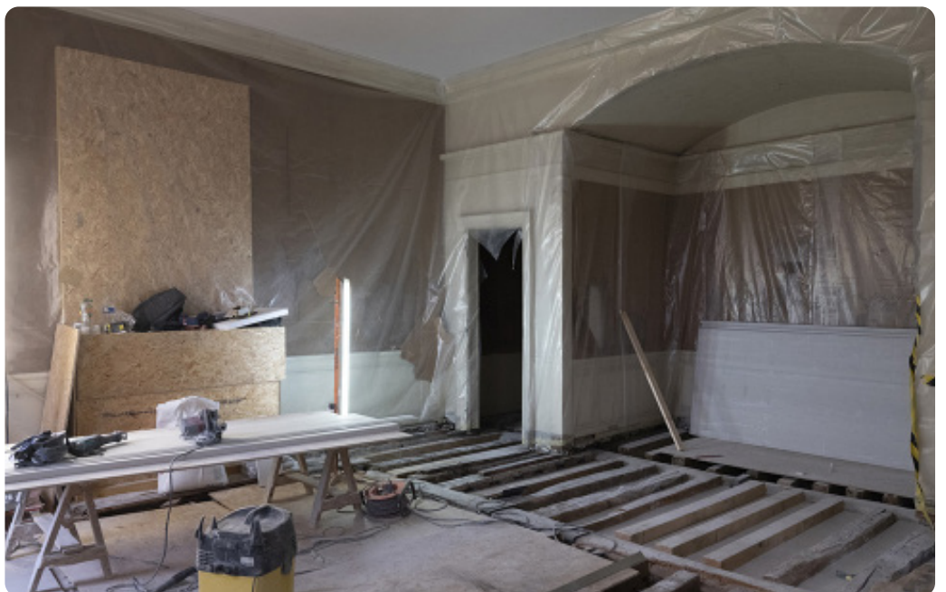
Stabilisation structurelle (par injection de résine) du plancher haut de la bibliothèque par le dessus (apprtements topographiques de l'Empereur au deuxième étage du château), décembre 2024. © Sylvain Duffard / Oppic 2024
